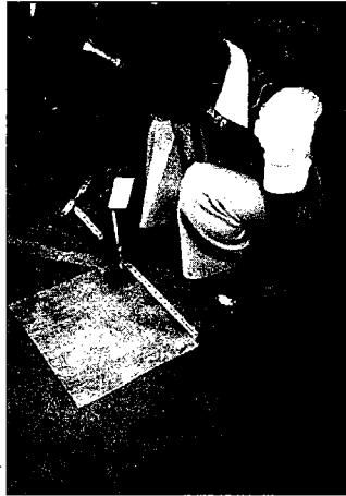
2. Luego dibuja las medidas en una lámina de aluminio y hace los cortes necesarios.
